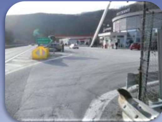
Italija PUO "Giovi zapad" Detalj negativnog primjera – ulaz i horizontalna signalizacija
